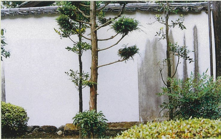
SEPホワイト施工後 ← → 施工前
