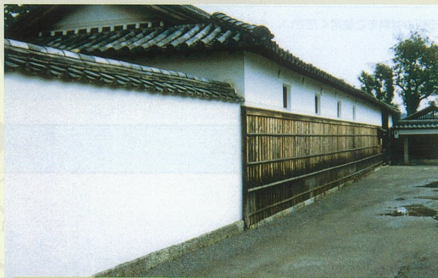
重要文化財永富家住宅、 しっくい土塀
